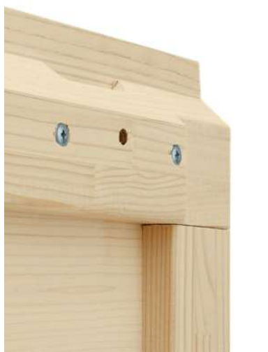
Extrémités des sections renforcées
